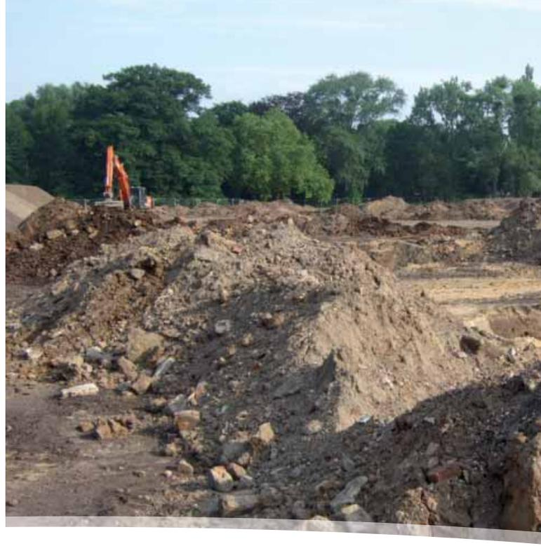
Zudem war der Baugrund nahezu wasserundurchlässig. Ein Dränsystem zur Entwässerung war erforderlich. Eine Abführung des anfallenden Oberflächenwassers und des Dränwassers in den Ostparkweiher wurde nicht gestattet. Ein Anschluss an die Kanalisation stand nicht zur Verfügung. Daher wurden Rigolenkörper im Boden unter der Sportanlage vor-
